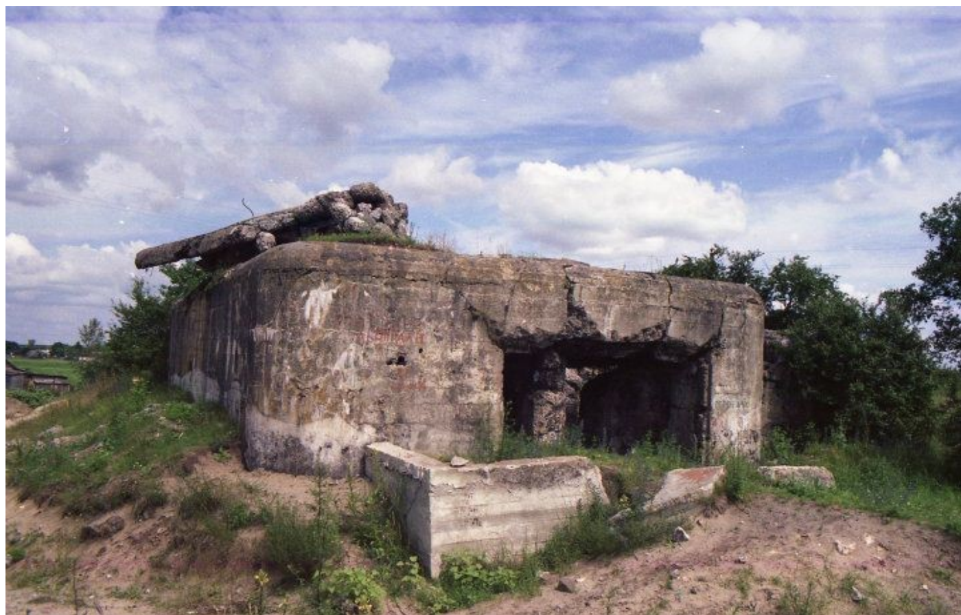
Zniszczony schron bojowy nr 9. Fot. T. Rodziewicz, Ppor. Jan Bołbott (1911-1939) , Lublin 2008.
